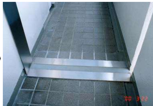
鉄板製の損傷したエキスパンションジョイントをアルミ合金製のものに付け替え
