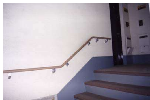
共用階段への手すり設置
