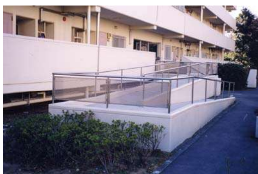
1階共用外廊下へのスロープ設置
