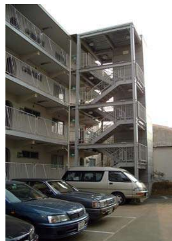
既存外廊下に増築したEV棟・外階段と一体化している
