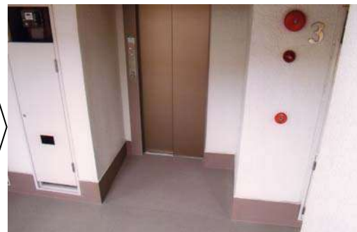
エレベーター出入り口の段差の擦り付け
