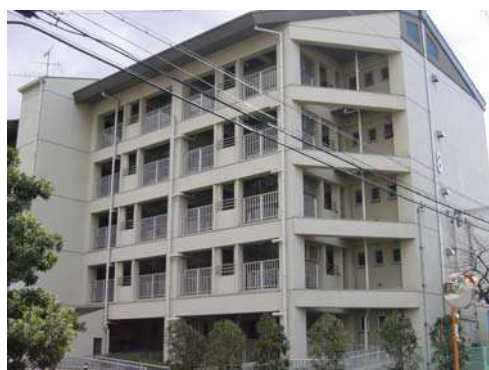
増築部分を北側から見たところ
