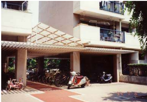
1階のピロティ部分の鉄骨ブレース補強(工事中)
