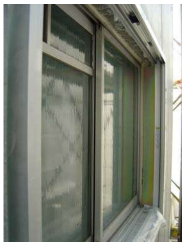
外付け工法による窓サッシの2重化
