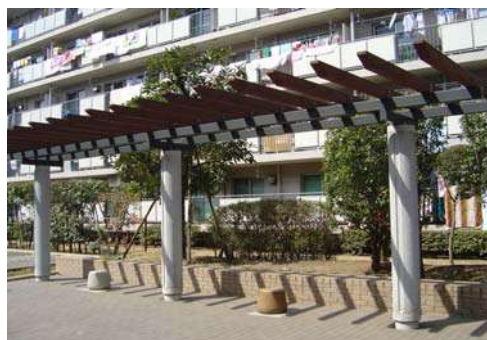
パーゴラ・ベンチの設置
