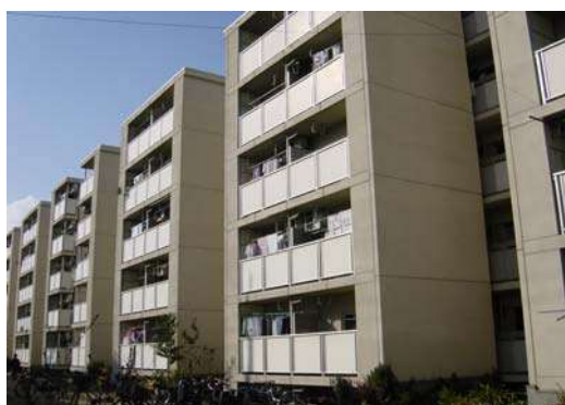
南側から見た増築した住棟
