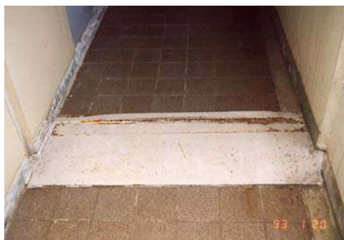
鉄板製の損傷したエキスパンションジョイントをアルミ合金製のものに付け替え
